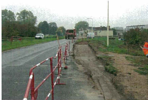
Réaménagement du chemin de la Cuve (derrière l'église)
